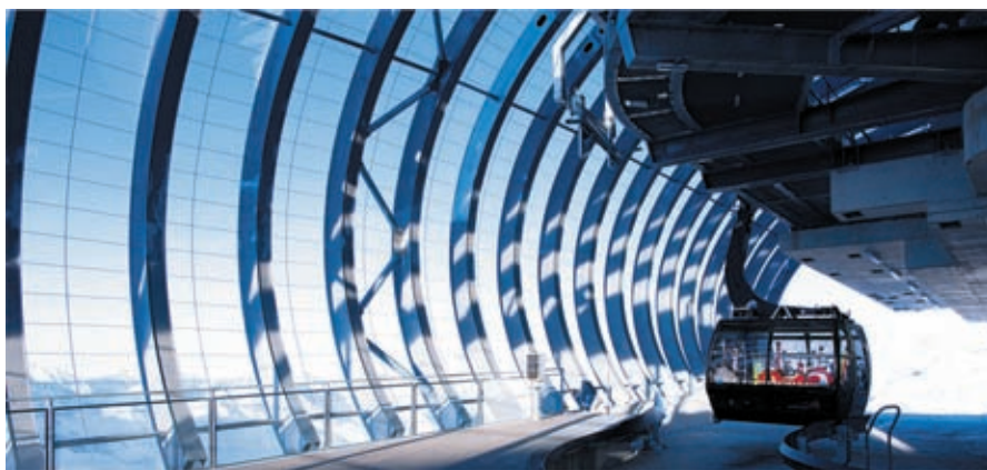
Фото 5. Фасад верхней станции канатной дороги на лыжной горе Гайслахкогль (Австрия). ETFE-пленке (Nowoflon ET 6235Z) приходится противостоять здесь мощным ветрам, а также выдерживать низкие температуры и интенсивное воздействие ультрафиолетового излучения (источник: A. Niederstrasser)
