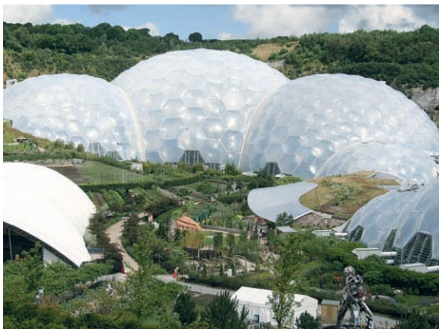
Фото 6. Биомы проекта Eden в Корнуолле (Великобритания) представляют собой конструкции, состоящие из подушек, изготовленных из ETFE. Пленки из ETFE-материала компании Dyneon пропускают 90 % видимого света и 80 % падающего на них УФ-излучения ближнего диапазона
