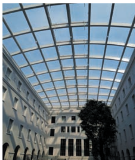
Фото 2. Внутренний двор Центра Уильяма Раппарда – главного здания Всемирной торговой организации в Женеве – имеет покрытие из ETFE-пленки Nowoflon ET 6235Z. Под этой самоочищающейся прозрачной конструкцией могут даже успешно расти растения (источник: WTO)
